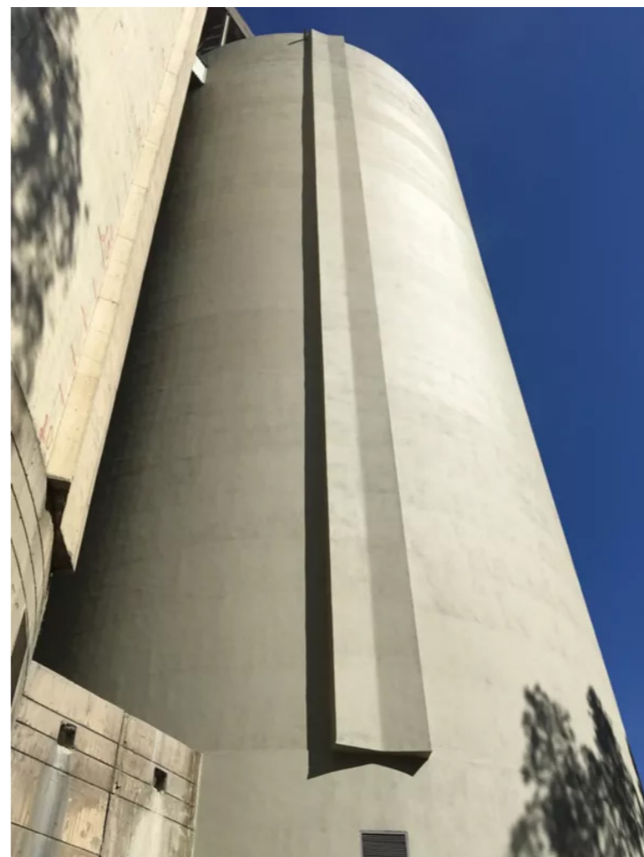
Após trabalhos de reparação.
